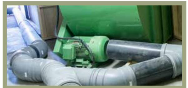
Hohe Temperaturen im Trocknungsraum wirken sich negativ auf die Lebensdauer der Antriebsmotoren aus. Über Rohrsysteme lässt sich ein einfaches Kühlsystem installieren.
