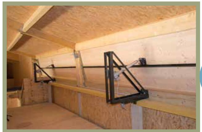
*Bei schönem Wetter heizt sich das Dach auf. Diese warme Luft wird abgesaugt. In der Nacht oder bei Schlechtwetter kann bei Entfeuchterbetrieb auf ein Kreislaufsystem geschaltet werden.*
