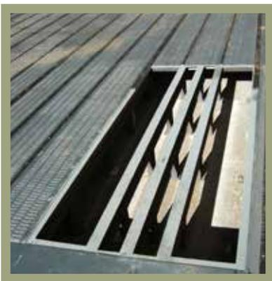
*Die Kiemenblechtrocknung ist je nach Unterkonstruktion befahrbar*
