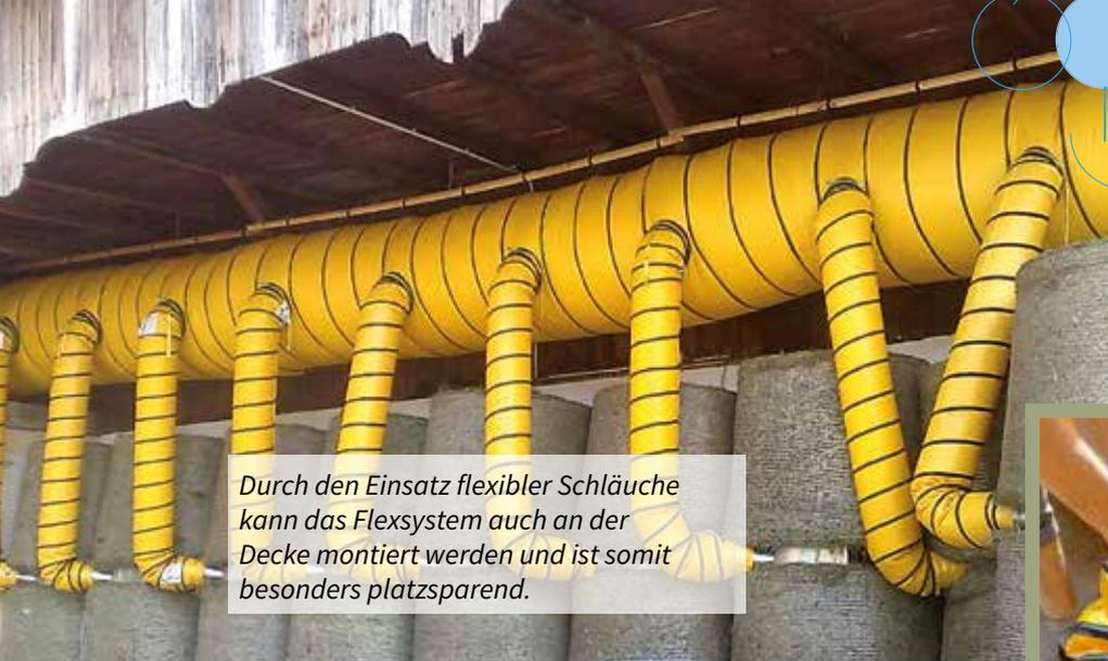
Durch den Einsatz flexibler Schläuche kann das Flexsystem auch an der Decke montiert werden und ist somit besonders platzsparend.
