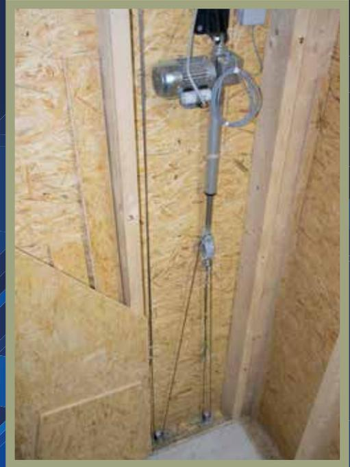
*Mittels Hubzylinder schaltet die Steuerung automatisch von Frischluft- auf Umluftbetrieb.*
