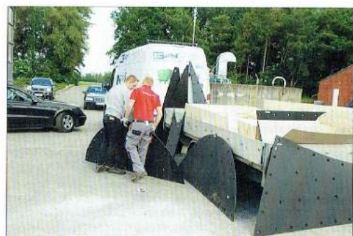
Die Robalon-Verkleidung wird im Werk in Österreich vorgefertigt und in Einzelstücken zur Baustelle transportiert.
