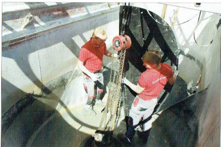
Zum Auskleiden werden auch die Getriebe der Mischschnecken angehoben, damit die Verkleidung darunter verlegt werden kann.
