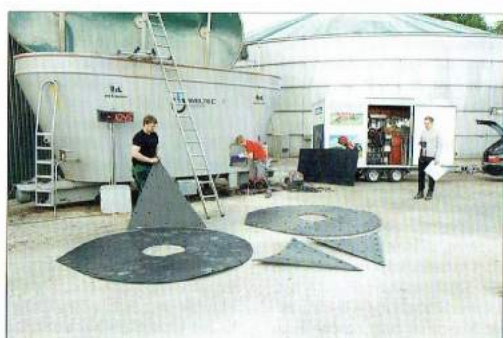
Die Platten werden zunächst so angeordnet, wie sie später im Behälter verlegt werden.
